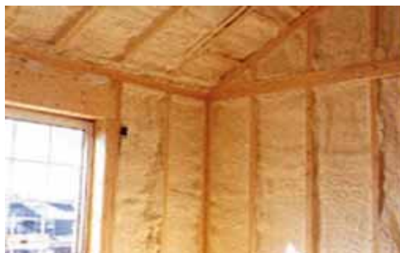
После окончания процесса видно, что задувка неоднородная и ее плотность низкая.
