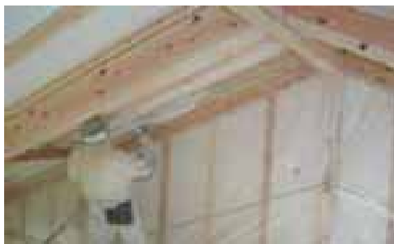
Процесс задувания уретана.
